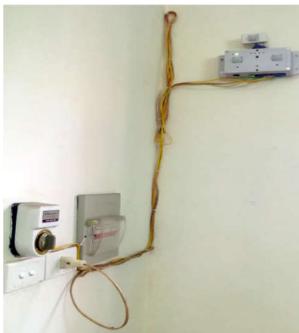
Hình 9. Kết quả lắp đặt bộ điều khiển
