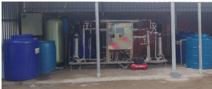
Hình 2. Mô hình hệ thống NF hai bậc xử lý nước nhiễm mặn
