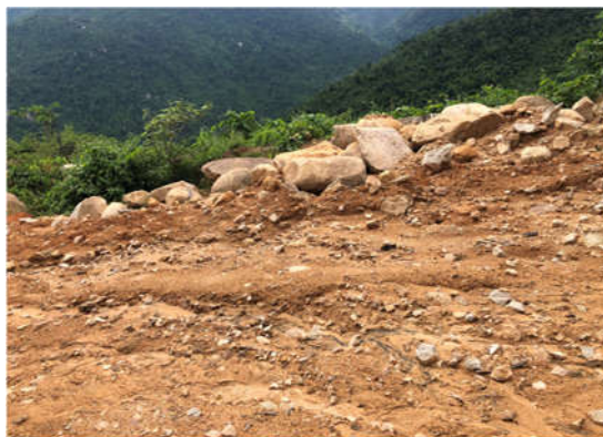
Hình 2. Mở đường lâm nghiệp tại trạm Đốc Mỏ
