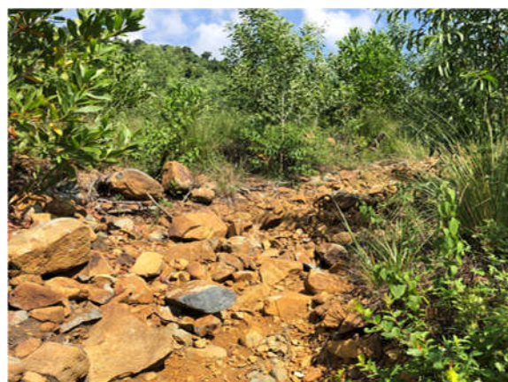
Hình 5. Xói mòn trong các lô rừng trồng ở trạm Hốc Chim
