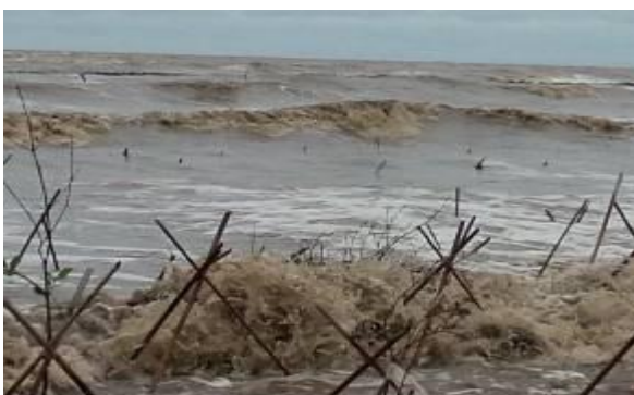
Hình 6. Cọc cắm tiêu tán và cây ngập mặn bị chết tại Trần Văn Thời, tỉnh Cà Mau
